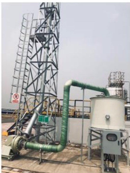
图 4.2-6 罐区排气筒及标识
