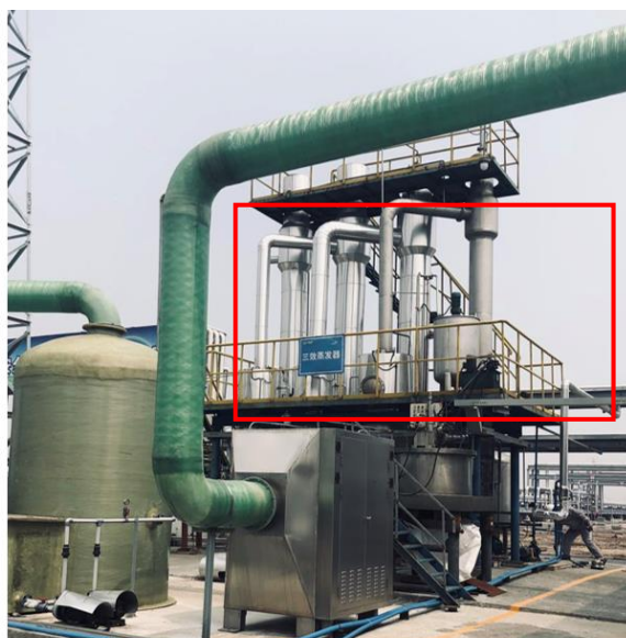
图 4.1-4 三效蒸发装置。
