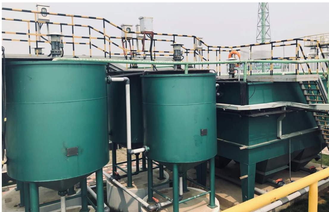
图 4.1-5 还原+中和+絮凝+斜管沉淀。
