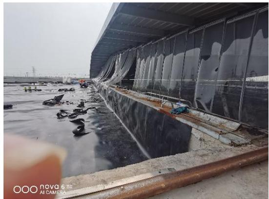
刚性填埋区地下一层目视检漏室地面为环氧自流平防腐蚀防渗混凝土地面，检漏层的防水等级为一级。填埋单元有防渗系统，填埋单元侧壁内涂环氧沥青，填埋单元设独立雨棚进行封盖，避免降雨进入填埋单元格。
