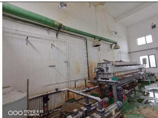
污泥脱水间地面是环氧自流平防腐蚀防渗混凝土地面，且有废水收集槽
