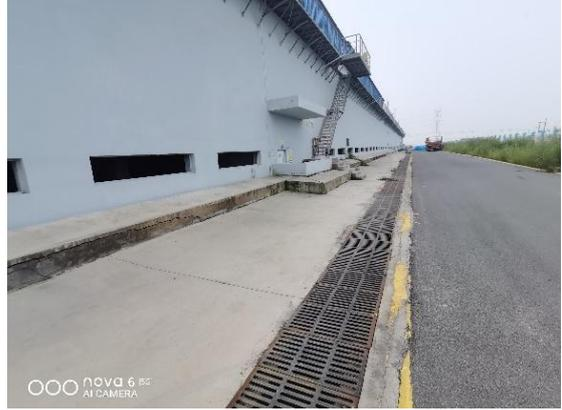
刚性填埋区路面有硬化，两侧均有废水收集槽。
