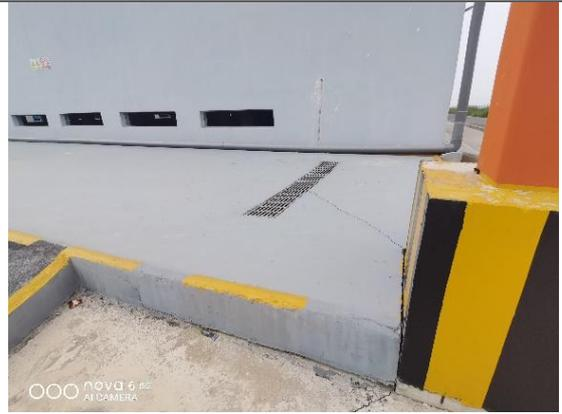
刚性填埋场装区地面是环氧自流平防腐蚀防渗混凝土地面，且有废水收集槽。
