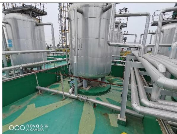
可燃废液储罐围堰内部防渗收集导槽
